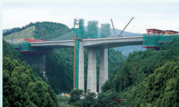
新東名高速道路 都田川橋
