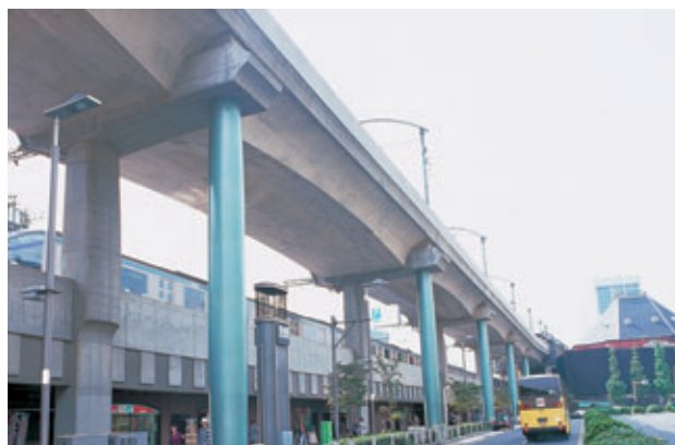
JR 中央線東京駅付近重層化PC高架橋
