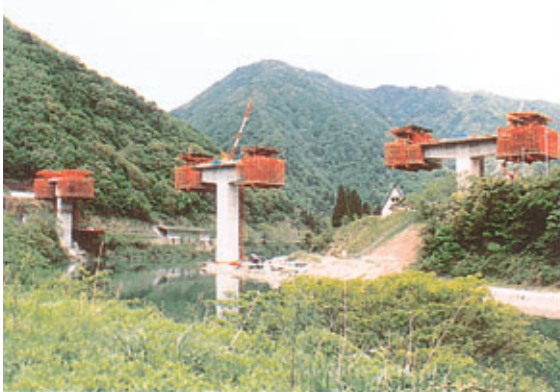
東海北陸自動車道 五箇山橋
