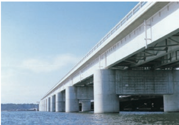
桥柱 (PC沉井工法)
