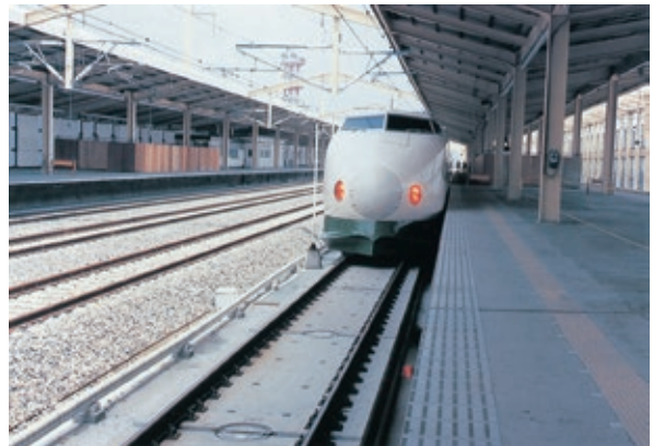
板式轨道·枕木
