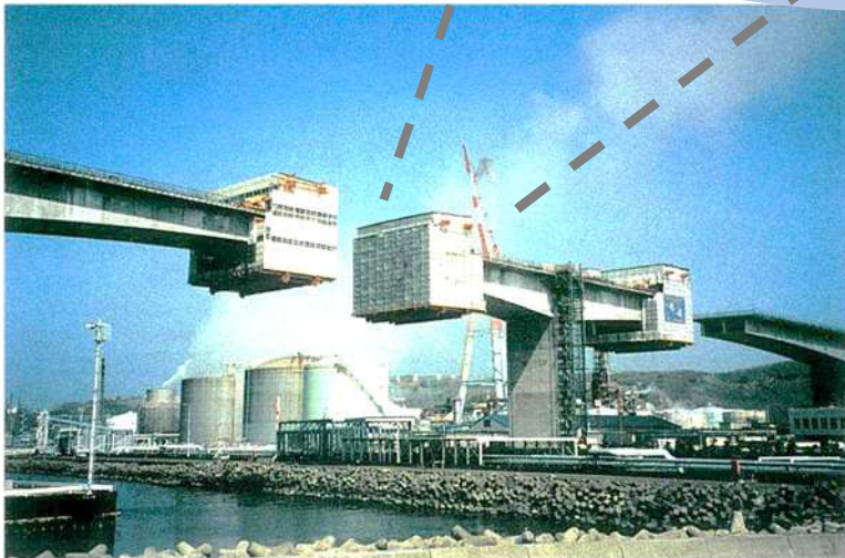
桁橋の張出架設工法のイメージ
