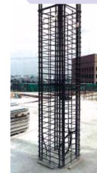
高強度せん断補強筋1275
