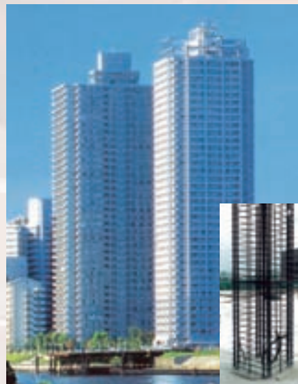
ウルボン1275を使用した建物と施工例（写真右下）
