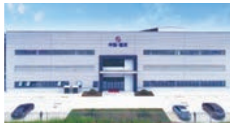
上海中煉線材有限公司重慶分公司 外観
