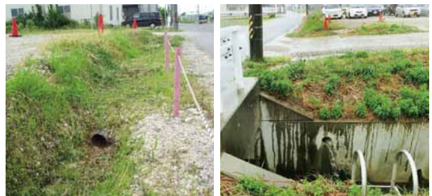
排水パイプを設置し、雨水を農水路へ
