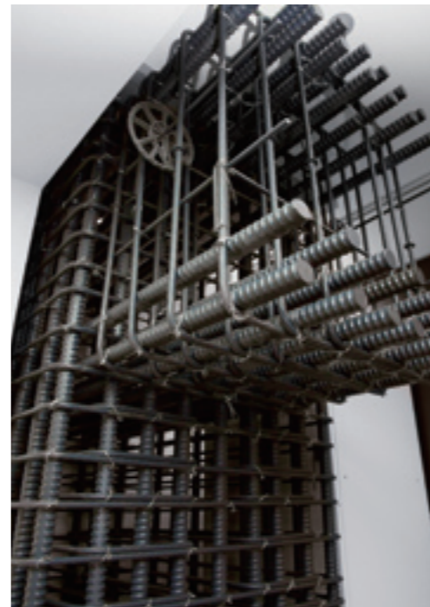
1275 高強度せん断補強筋施工モデル
