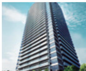
ダブルスターク®が採用される高層マンション「リーフィアタワー海老名アクロスコート」(三井住友建設(株)が建設予定)
