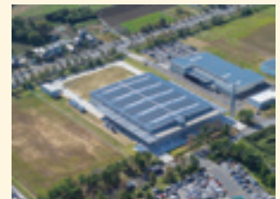
茨城工場の太陽光発電システム
