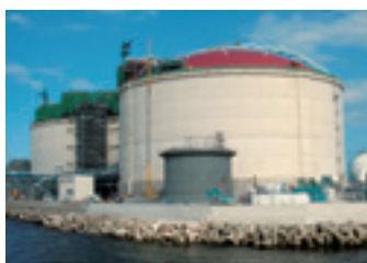
NetzレンのアンボンドPC鋼棒を使用したPCLNG貯槽
