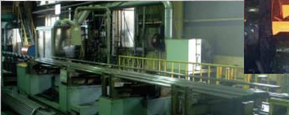
長尺管の焼入状況
