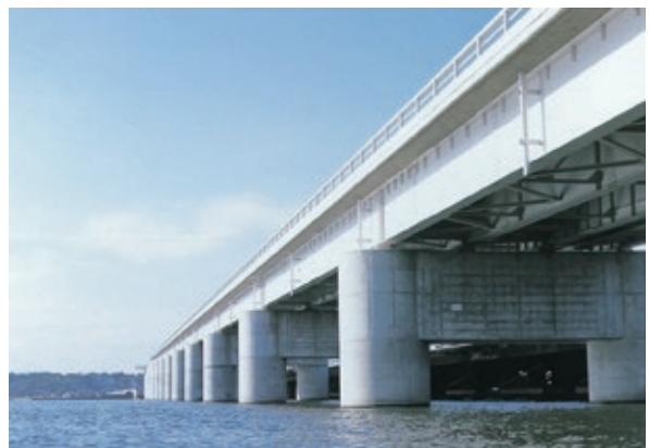
橋脚 (PCウェル工法)
