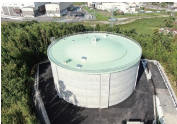
PCタンク・LNGタンク
