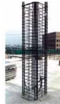
高強度せん断 補強筋1275
