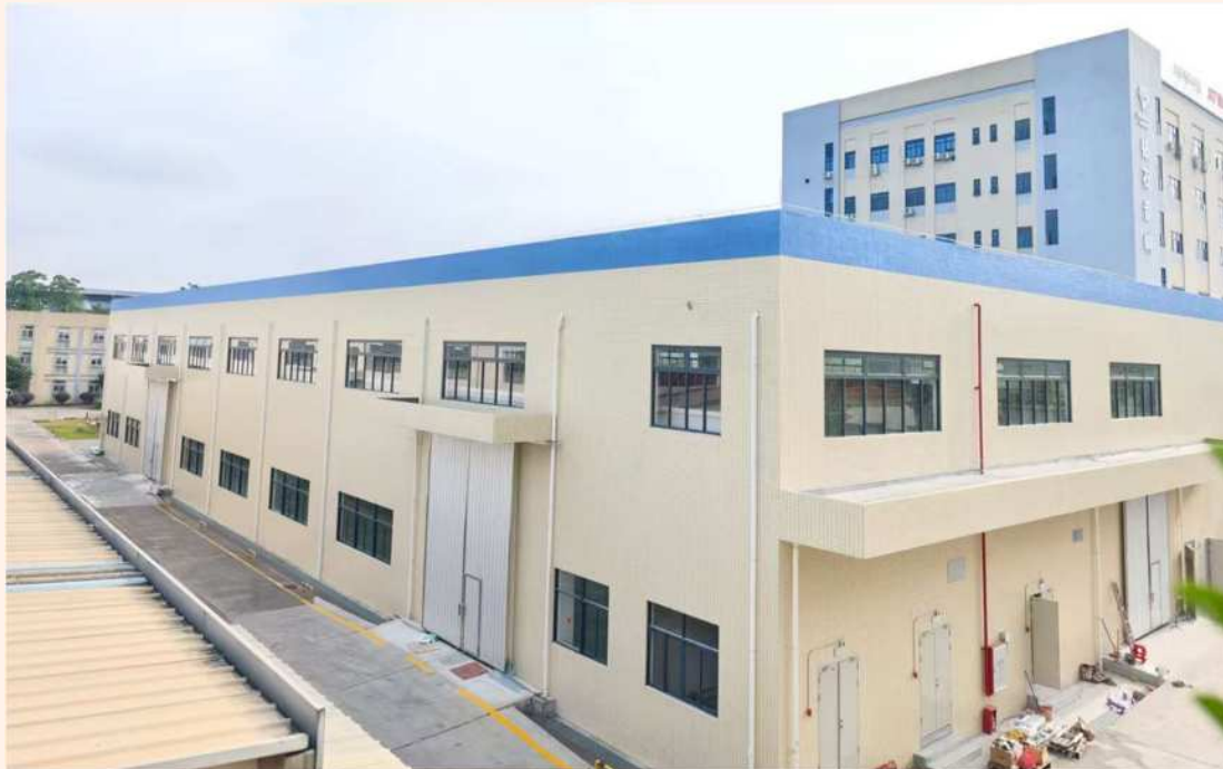
第2工場の外観
