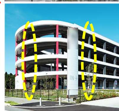
倉庫等の 耐震補強に採用
