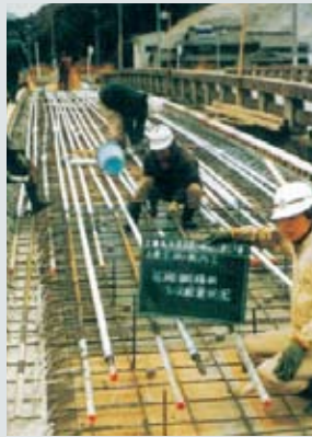
圧縮PC鋼材配置
