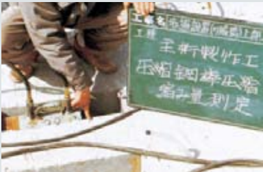
圧縮PC鋼材配置の短縮量測定
