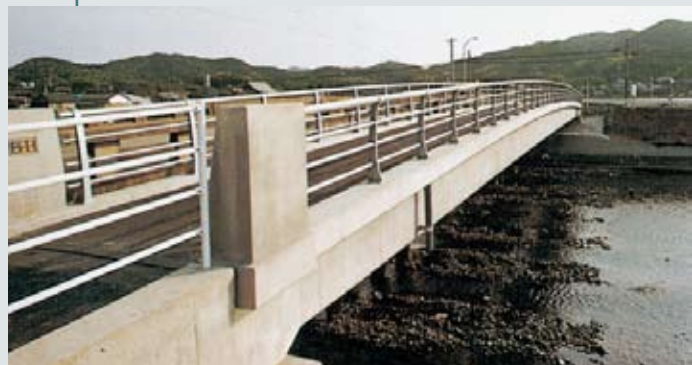
日本で最初のパイプ工法施工例 (川端橋側道橋)
