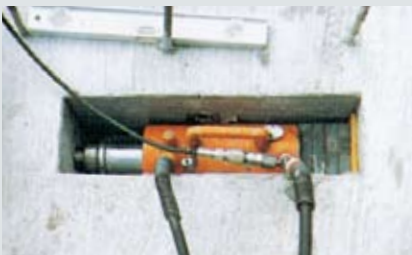
センターホールジャッキ取付け状態
