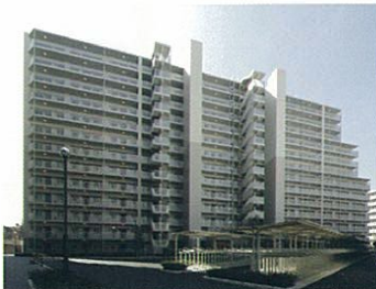
RC造13階 共同住宅
