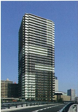
RC造34階 共同住宅
