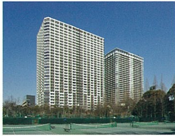
RC造33階 共同住宅
