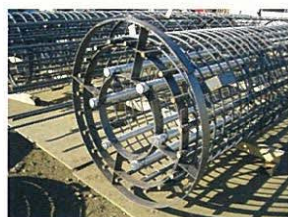
鉄筋かご(杭頭部)
