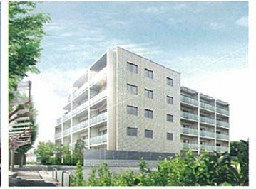
RC造5階 共同住宅
