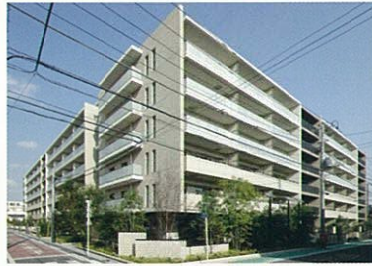
RC造6階 共同住宅
